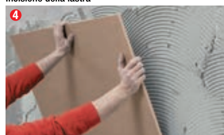
4 Installare la lastra sulla parete
